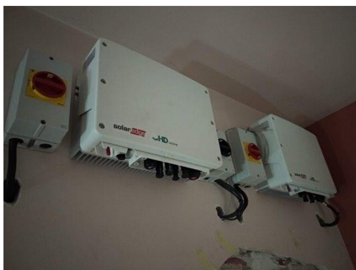
Figure 13 Solar edge inverters
